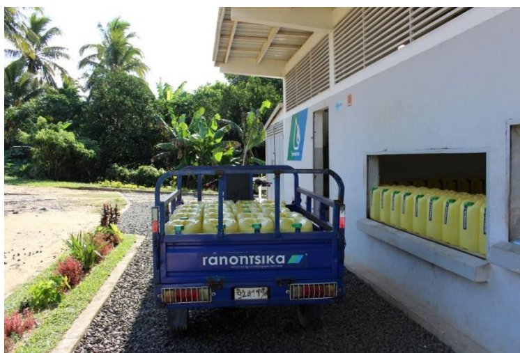
Fig.1 : Une station de production, de traitement et de distribution (site C8 – Antetezambaro)
